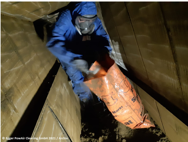
Persönliche Schutzausrüstung (PSA) für PowAir Cleaner mit Atemschutzmaske und Frischluftzufuhr ist bei Egger PowAir Cleaning Pflicht (Bild 1)
