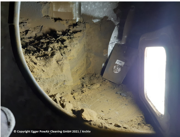
Bergmännische Entfernung der Ablagerungen (Bild 4)
